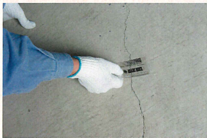
① ひび割れの調査
