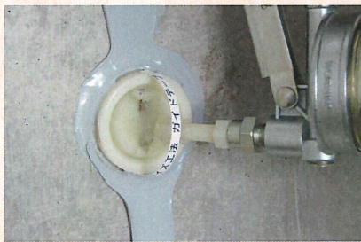
⑧ 注入・養生
